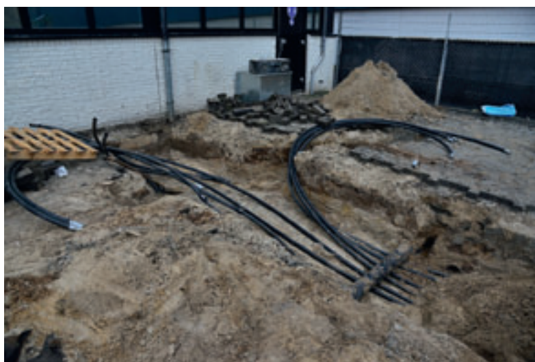
De bodembron die in 2014 is geboord bij het kantoorpand van Nibe in Oosterhout.
